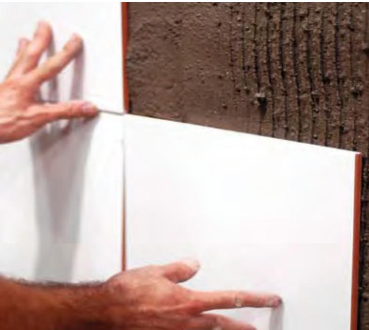
Adhesivo cementoso de uso interior, para la colocación en capa fina de piezas cerámicas de absorción media y alta sobre soportes de enfoscado de mortero en pavimentos o revestimientos.
