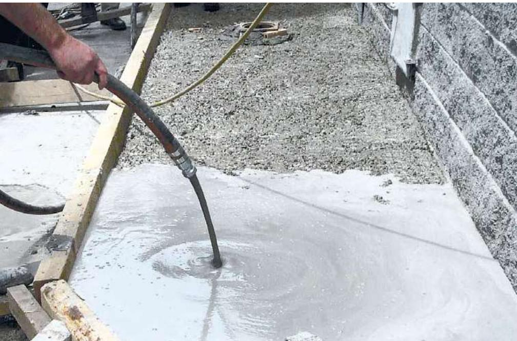
Mortero autonivelante para aplicaciones de recrecio en capa gruesa, en espesores comprendidos entre 2 y 10 cm.
