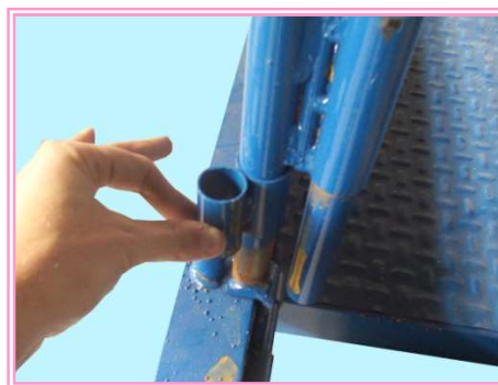
Fig.12: Vista proceso de colocación de seguros.
