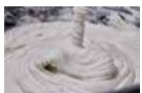
Amasar webercol FLEX S1 con la cantidad de agua limpia indicada en la tabla final, por saco de 25 kg, con un batidor eléctrico lento (500 rpm) hasta obtener una masa homogénea y exenta de grumos. Dejar reposar la mezcla unos 2 minutos y realizar un ligero reamasado.
