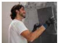
Colocar las baldosas presionándolas hasta conseguir el aplastamiento de los surcos del mortero cola y un buen macizado de la pieza. Comprobar periódicamente la pegajosidad de la pasta levantando la baldosa previamente colocada. Es aconsejable dejar juntas entre piezas colocando crucetas de 2 mm como mínimo en interiores y 5 mm en exteriores, rellenándolas con morteros de rejuntado de la gama **webercolor**.
