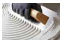
Aplicar con una llana dentada para regularizar el espesor en paños pequeños de máximo 2 m<sup>2</sup>. Respetar el tiempo abierto del adhesivo y en caso que se haya formado una película en la superficie del adhesivo y no existe transferencia, eliminar el material y aplicar de nuevo. Efectuar un doble encolado para piezas de gran formato o elevado peso
