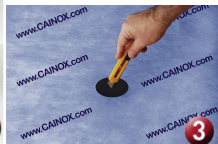
**3** Recorte el sobrante de tela sobre el orificio del sifón donde conectará el tubo de la canal, con cuidado de no dañar la junta de EPDM del sifón ni la tela colocada.
