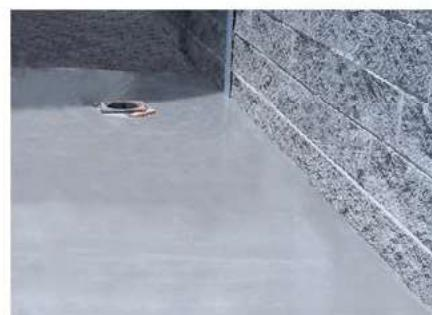
Mortero autonivelante para aplicaciones de recrecio en capa gruesa, en espesores comprendidos entre 2 y 10 mm.
